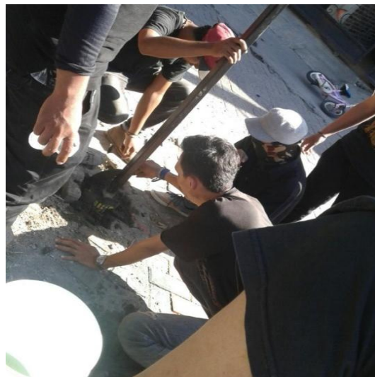
Pemasangan Papan Jalan Baru (Hari Minggu: 16/07/2017)
