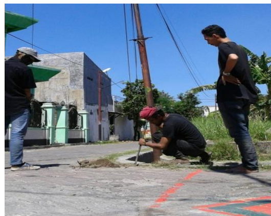
Pembongkaran Papan Jalan Lama (Hari Sabtu: 15/07/2017)
