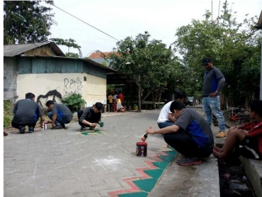
Pebersihan dan pengecatan paving (Hari jum'at: 14/07/2017)
