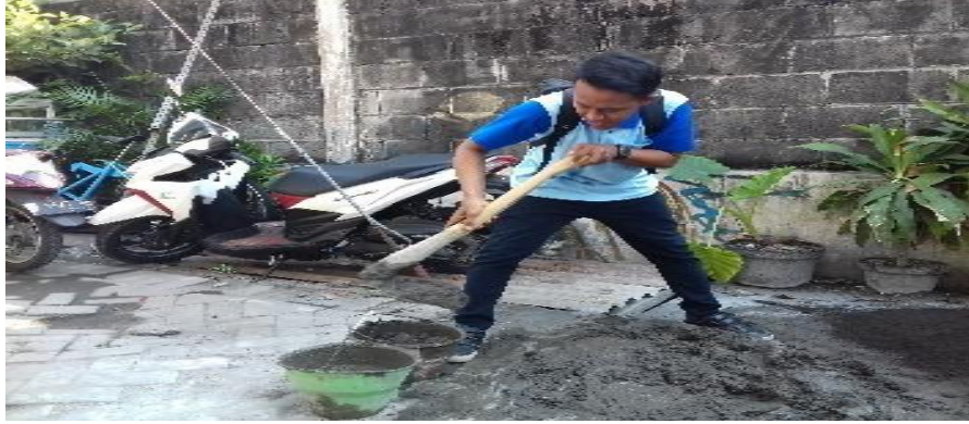
Pembuatan campuran beton untuk plesteran
