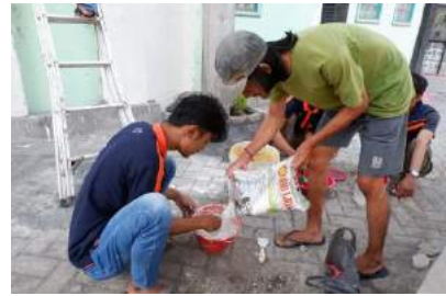
GAMBAR 3 PEMBUATAN ACI
