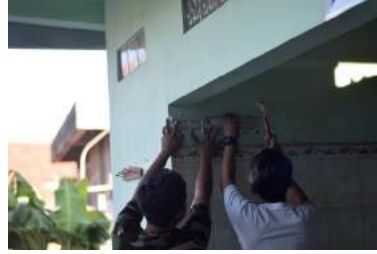
GAMBAR 13 PEMASANGAN INVENTARIS GANTUNGAN
