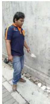
Gambar 8 Membersihan sampah Yang ada di selokan
